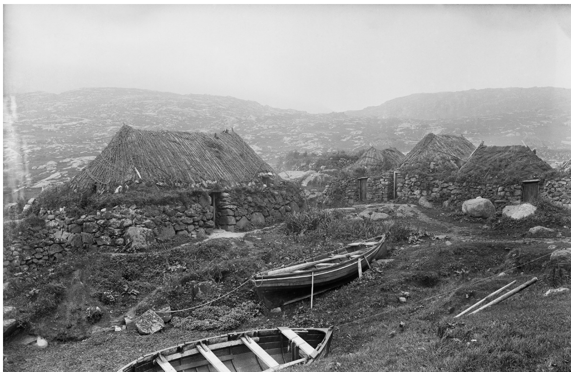
Fig. 7 – Black houses à Ceann Tangabhal (Kentangaval), île de Barra, Hébrides. Noter les pierres posées de chant à la base des murs de la maison de gauche (photographie Erskine Beveridge, 1898, © RCAHMS).
