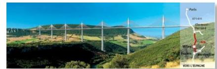
Deux autres ingénieurs ont dirigé le chantier, l'un pour la construction des piles avec la pile la plus haute du monde (245 m), l'autre pour la construction du tablier métallique de 2,5 km de long.
