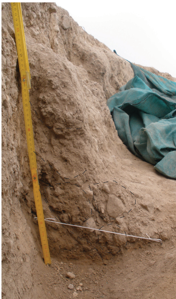
Fig. 2 – Mur périphérique. La partie inférieure est ancrée dans la tranchée de fondation (phase 1); la partie supérieure appartient à la phase 2.
