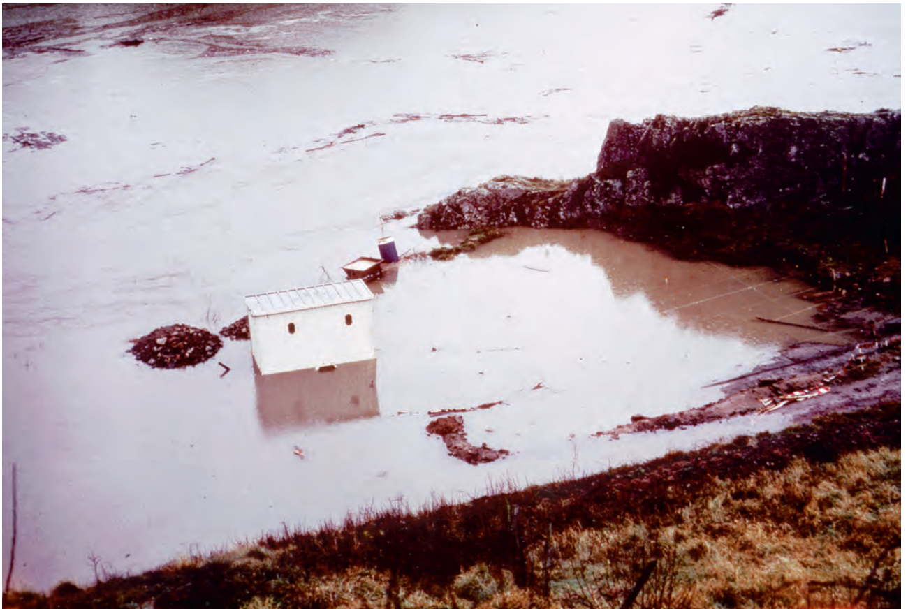
Fig. 2 – Envahissement du gisement du Rocher de la Caille par la mise en eau du lac créé par la barrage de Villerest (Décembre 1982).
