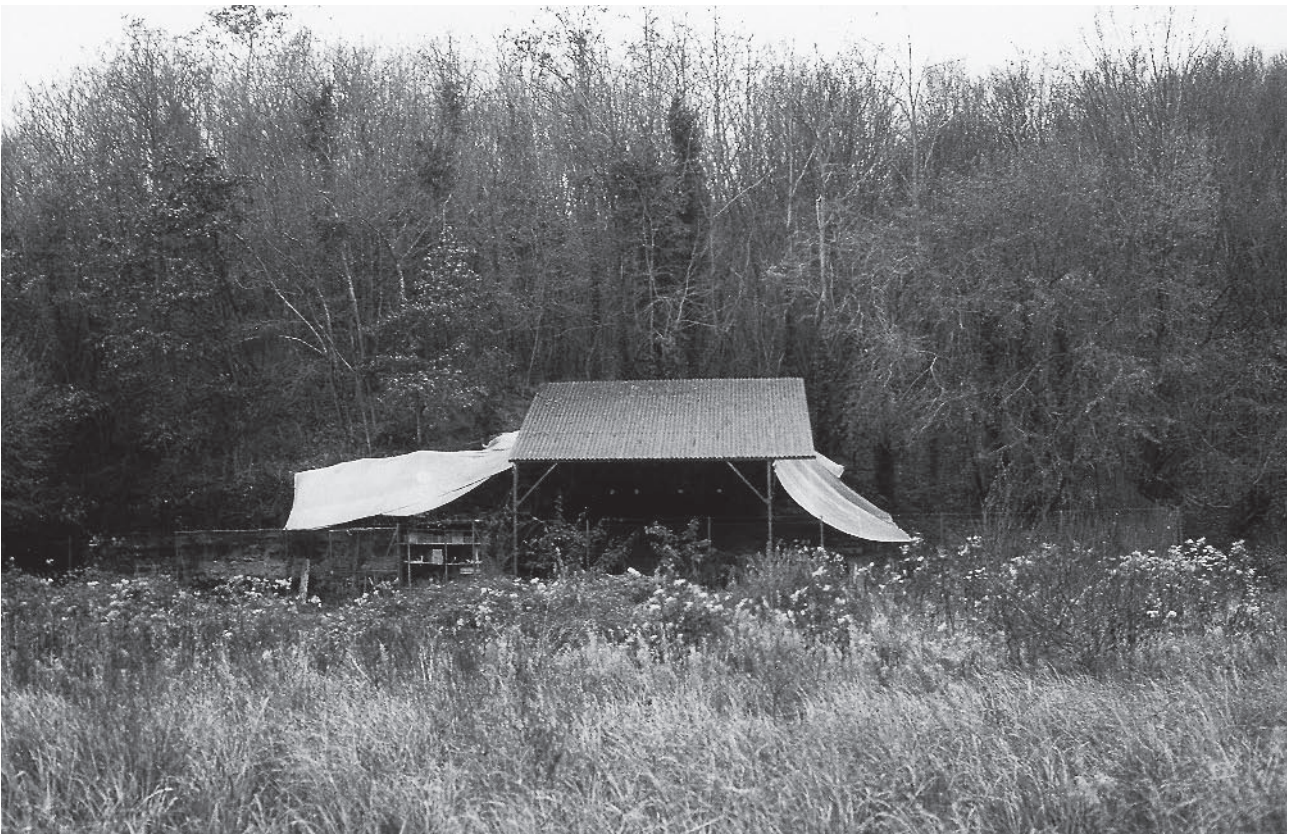
Fig. 3 – Le chantier après clôture et couverture.
