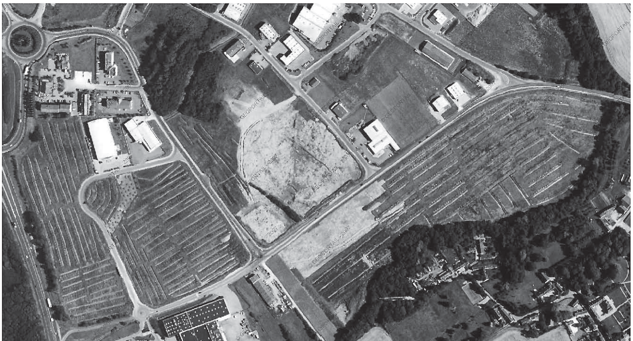
Fig. 2 – Succession des opérations menées sur le secteur de Macherin à Monéteau et vue aérienne à l'été 2001.
