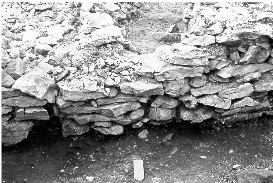
Fig. 3 – Ernes : paroi sud du couloir, contact entre la maçonnerie initiale (à droite) et le massif de contrefort (à gauche) (cliché J.-L. Dron).
