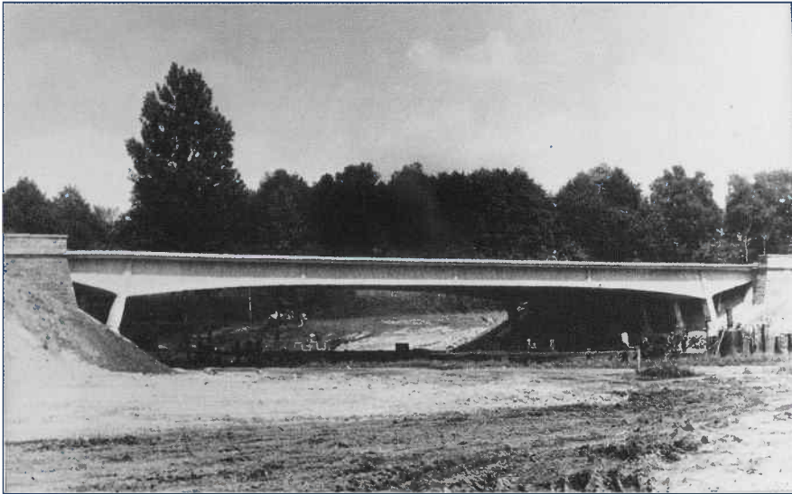
Photographie : J. Capel, construction de huit ponts en béton précontraint. Travaux 1954
