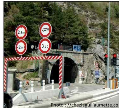
Tête sud du tunnel routier du col de Tende : on notera les importantes mesures de régulation du trafic.
