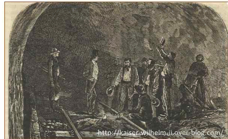
La pose du dernier rail dans le tunnel du Mont-Cenis
