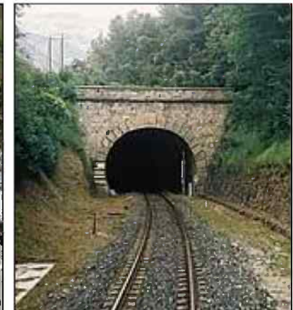
Tête sud du tunnel ferroviaire du col de Tende : une seule voie est installée au centre du tunnel.
