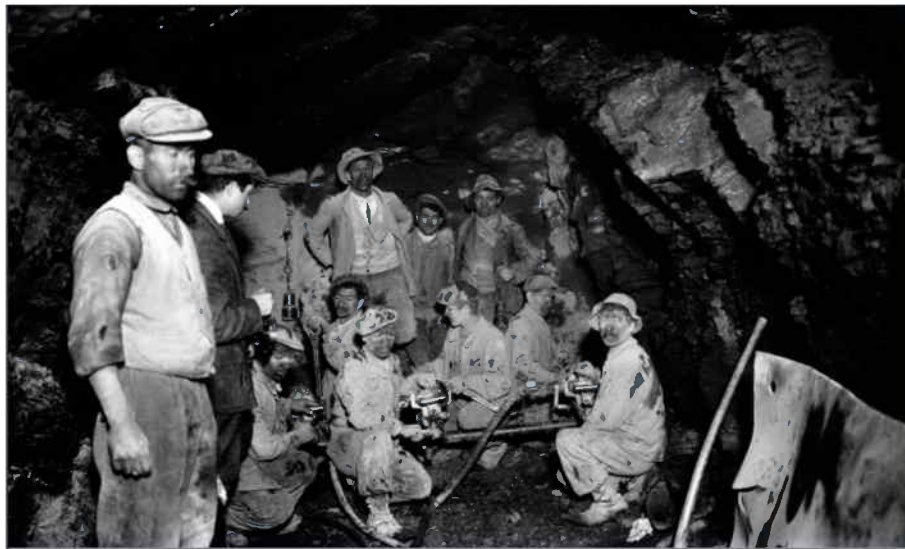
Percement du tunnel en cours
