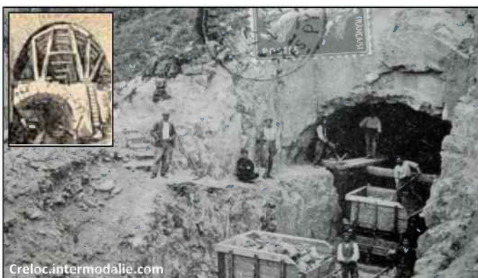
Creusement du tunnel au niveau du portail français.
