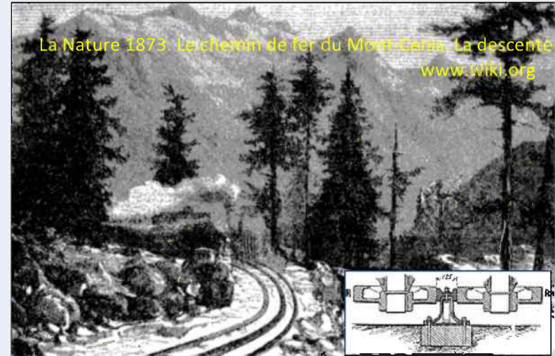
Noter le rail central typique du dispositif de Fell pour les fortes pentes
