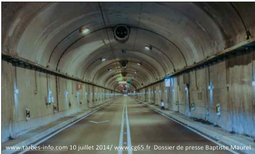
Intérieur du tunnel
