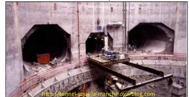
Débouché des tunnels dans le puits
