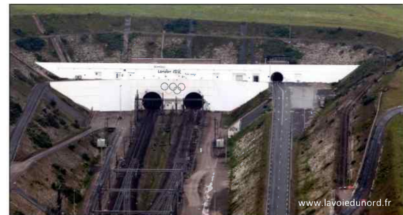
Tranchée de Beussingue (A droite la voie de service)
