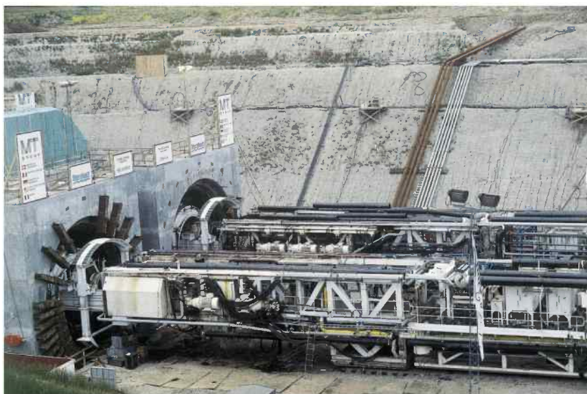
Vue des tunneliers
