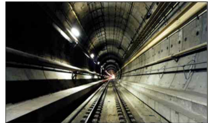
Tunnel ferroviaire avant équipement final et entrée en service
