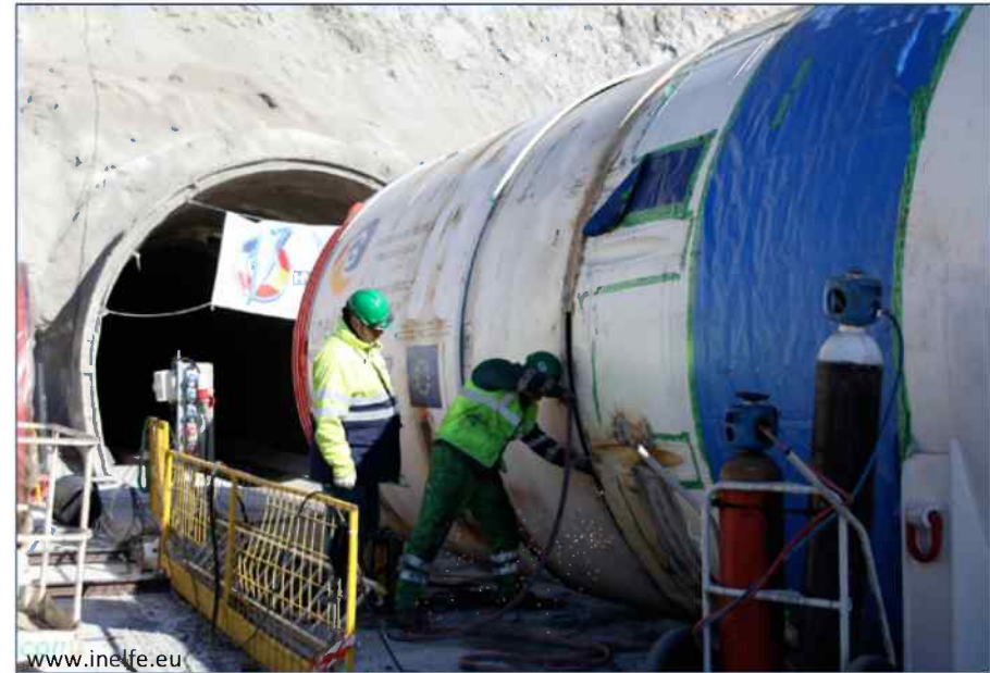
Installation du tunnelier côté espagnol
