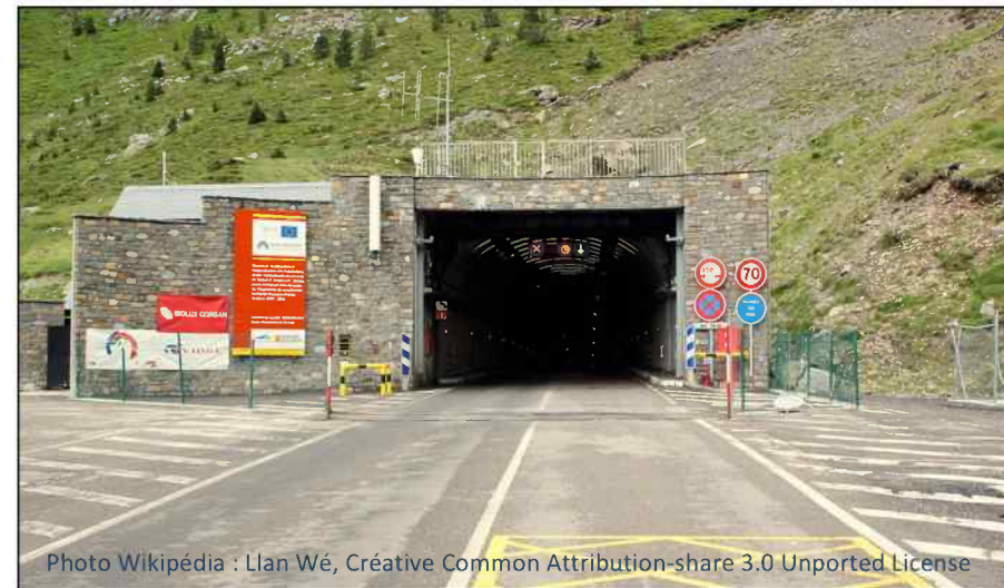
Entrée nord du tunnel (côté France)
