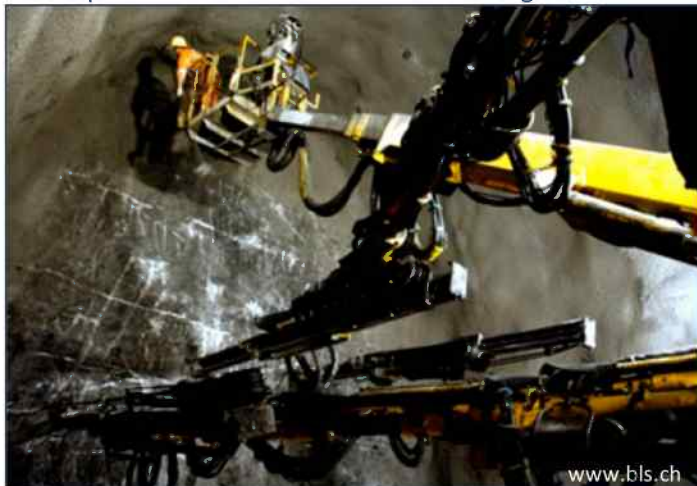
Creusement du tunnel par perforation et explosif
