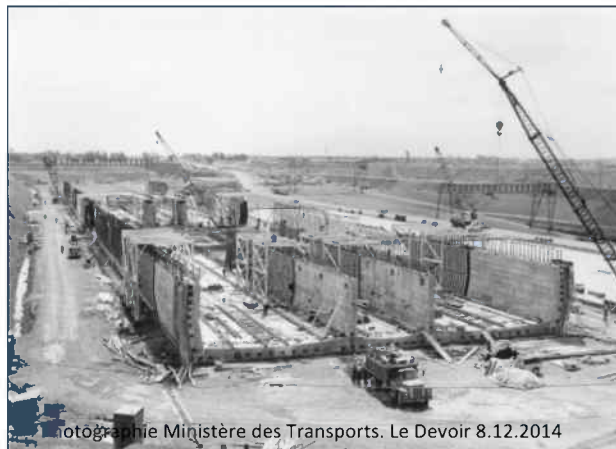
Construction du radier, des piliers et des cloisons
