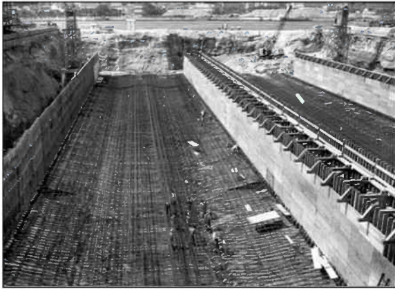
Construction du radier
