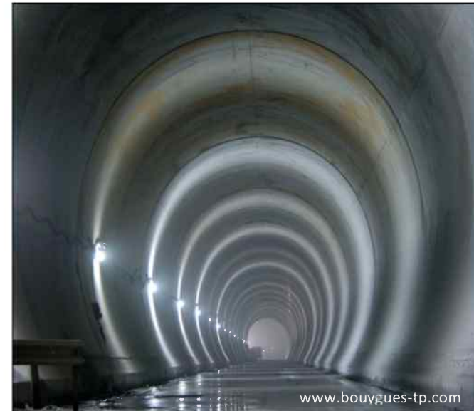
L'un des tunnels réalisés par Bouygues Travaux Publics
