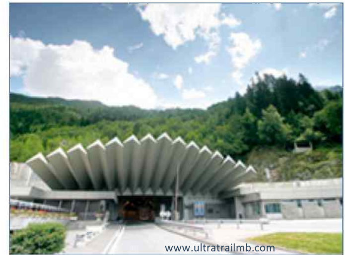
www.ultra-trailmb.com Entrée du tunnel côté France (A noter l'imposant porte à faux de la casquette)
