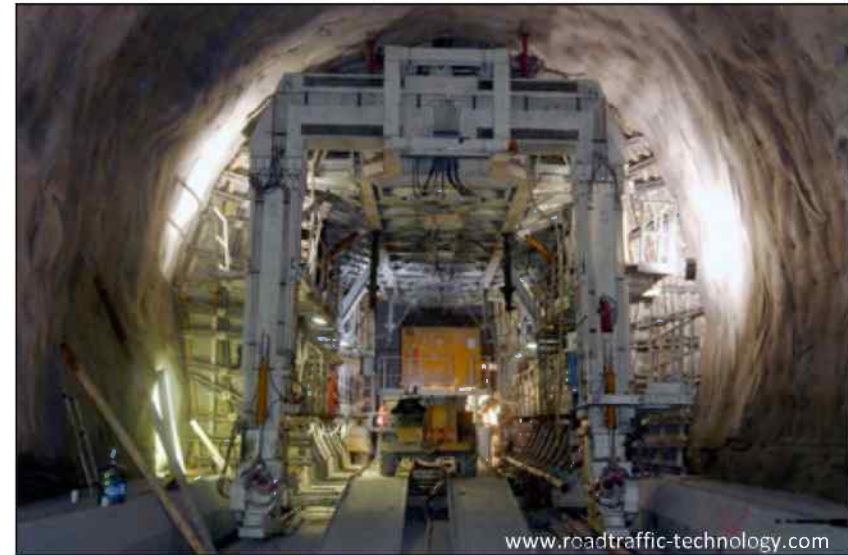
Travaux de drainage dans le tunnel en construction
