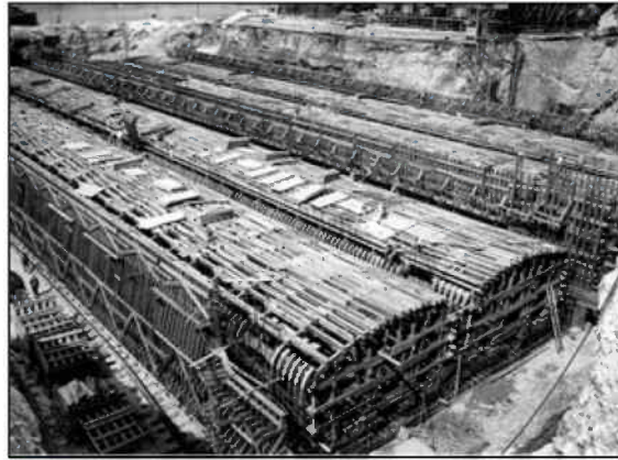
Réalisation des coffrages
