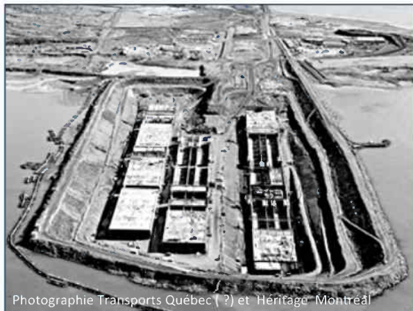
Cale sèche pour la construction des caissons
